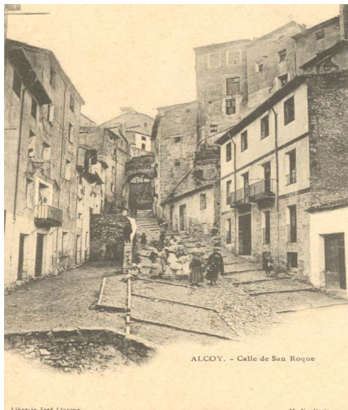
Viviendas de la calle San Roque (FMA)
