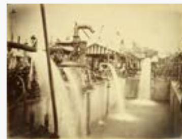
Exposició de motors elevadors d'aigua València, 1880. Fotografia apareguda a les obres de Garcia, 1980; Boix, 2016.
