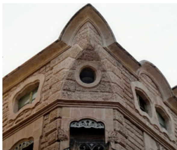
Fig. 9: Alero de la zona superior del edificio. Foto A. Corona.
